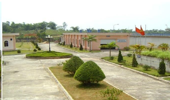
Nhà vận hành bơm
